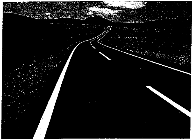
La valorización material de los NFU aplicada a la construcción de carreteras presenta numerosas ventajas.
