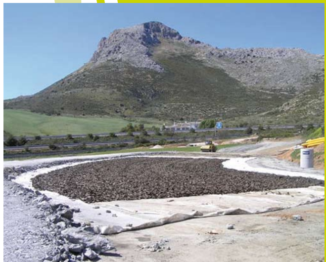
Proceso de construcción del terraplén a base de material triturado procedente de neumáticos fuera de uso.
