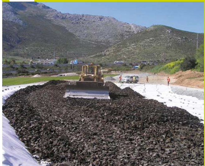
Proceso de construcción del terraplén a base de material triturado procedente de neumáticos fuera de uso.
