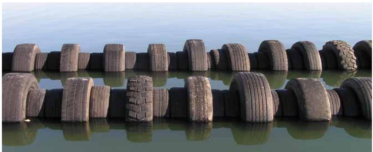
*Estructura de abrigo realizada con neumáticos*
