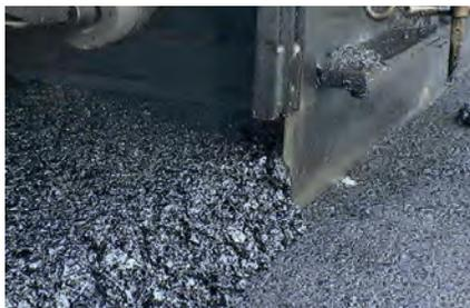
**Figura 16. Extensión de una capa de mezcla bituminosa**
