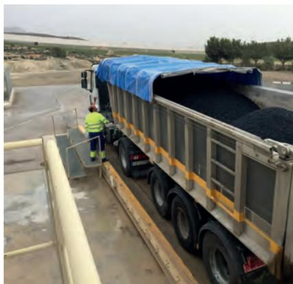
**Figura 15. Protección de la mezcla bituminosa con una lona durante el transporte.**
