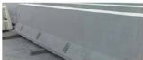
Barreras de seguridad en carretera
