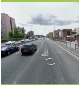
AÑO 2008 (antes de rehabilitación)
