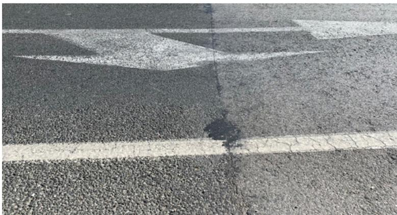
**Figura B.12. Detalle del aspecto de la mezcla fabricada con polvo de caucho por vía seca puesta en servicio en 2006 (izquierda) y de la mezcla convencional puesta en servicio en 2010 (derecha)**
