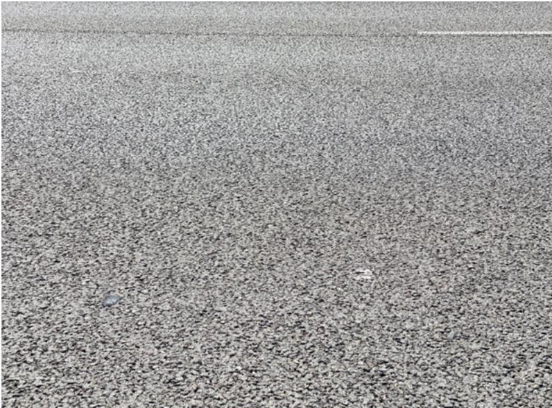
**Figura B.21. Detalle del estado actual de la mezcla con caucho por vía seca utilizada en la carretera N-301 (III)**
