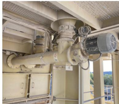
**Figura 18. Detalle de la zona de incorporación del polvo de caucho en las plantas discontinuas**
