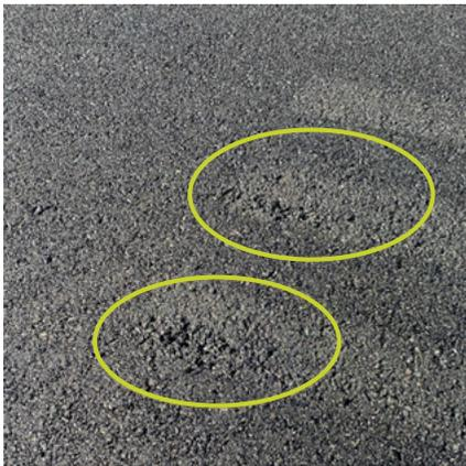
**Figura 22. Detalle de los posibles defectos producidos por el compactador de neumáticos**
