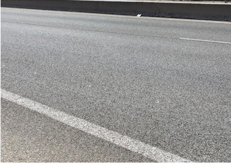
**Figura B.20. Detalle del estado actual de la mezcla con caucho por vía seca utilizada en la carretera N-301 (II)**
