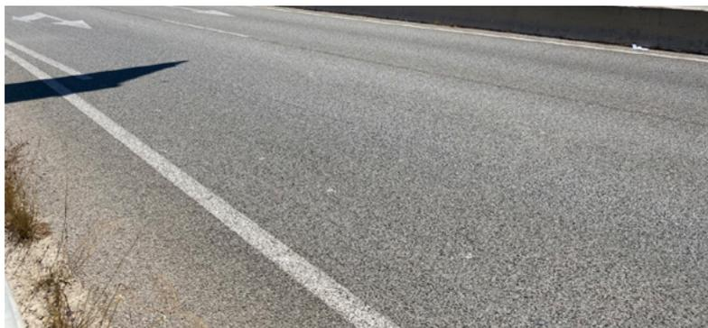
**Figura B. 18. Estado actual del tramo de carretera N-301 (BBTM 11B con polvo de caucho por vía seca)**
