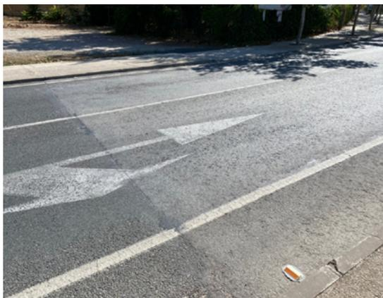
**Figura B.10. Zona de pendiente ascendente en carretera CV-846 y zona limítrofe entre los tramos rehabilitados en 2006 (izquierda, con mezcla fabricada con polvo de caucho por vía seca) y en 2010 (derecha, con mezcla convencional)**
