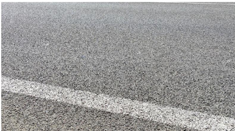
**Figura B. 19. Detalle del estado actual de la mezcla con caucho por vía seca utilizada en la carretera N-301 (I)**
