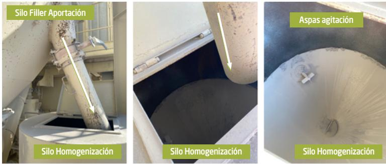
**Figura 16. Detalle de la conexión del silo de filler de aportación con el silo de homogeneización y del sistema de aspas de agitación de éste**
