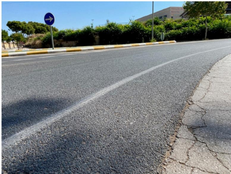
**Figura B.9. Detalle del aspecto de la mezcla fabricada con polvo de caucho por vía seca en la zona de giro**
