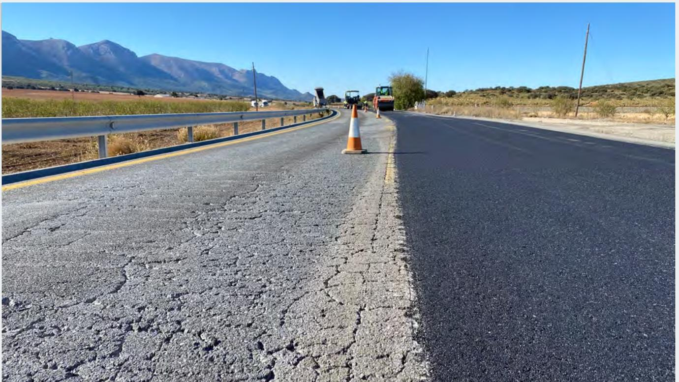
*A la izquierda firme deteriorado, a la derecha, firme rehabilitado con MASAI (II) compuesto por un 20% de material deteriorado procedente del propio firme, un 0,5% de polvo de caucho procedente de neumáticos usados, y fabricado a una temperatura máxima de 140 °C.*
